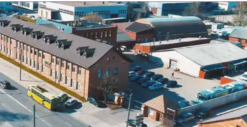
Firmenzentrale von Baltec CNC Technologies in Kaunas
