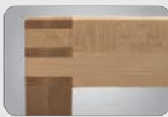
Fingerverzinkung in Hinterzange und Beiladerücken
